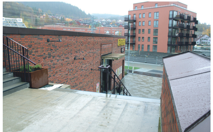
Fasadene i sokkeletasjene og også i bygget som gir plass til en nærbutikk er i tegl.
