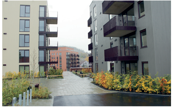
I fasadene er det brukt trepanel, bortsett fra at det er tegl som fasade i sokkeletasjene.
